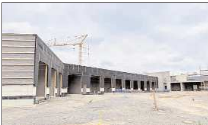
Im Rohbau ist die schiere Größe des Rettungsdienstzentrums des Landkreises Holzminden schon gut zu erkennen.
