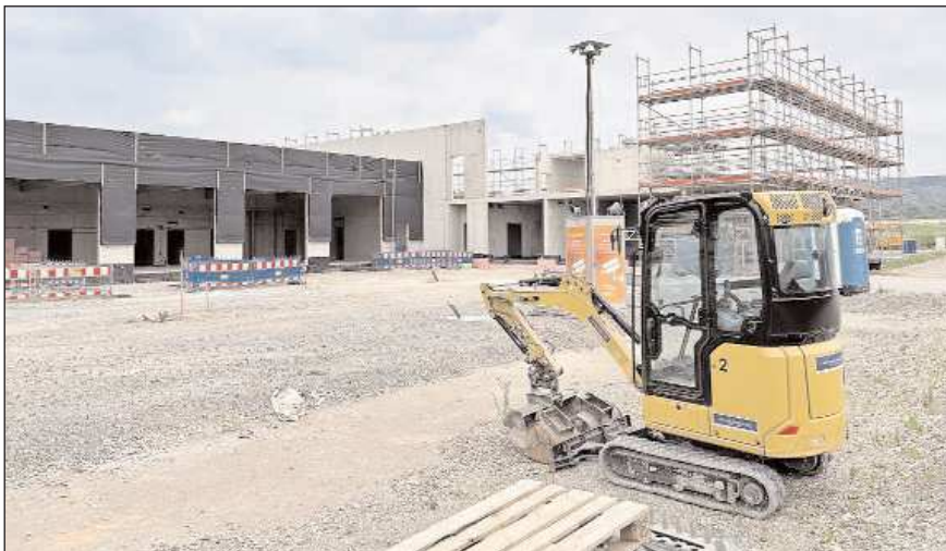
An manchen Tagen scheint derzeit die Baustelle des Rettungsdienstzentrums des Landkreises Holzminden zu ruhen.
