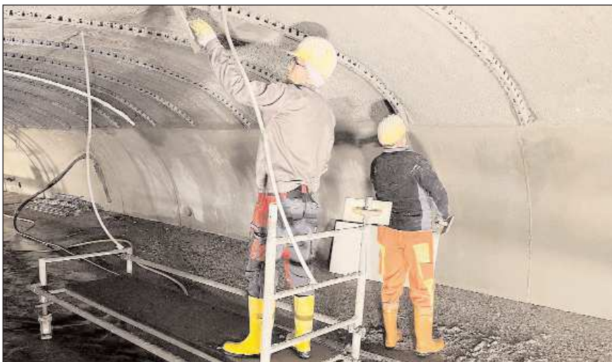
Im Tunnel unter dem Haarmannplatz laufen die letzten Arbeiten. Mit der Hand wird die Spritzbeton-Mörtelschicht ausgetrieben. FOTOS: BIRGIT SCHNEIDER
