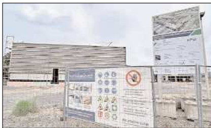
Stillstand hinter Bauzäunen? Auf der Baustelle an der Ferdinand-Tiemann-Straße geht es langsamer voran als geplant.
