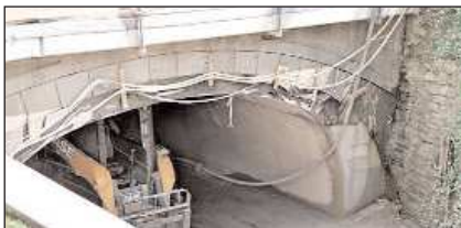
Neu gemacht wurde auch die Kappe der Haarmannplatz-Brücke, durch die die Herrenbache fließt
