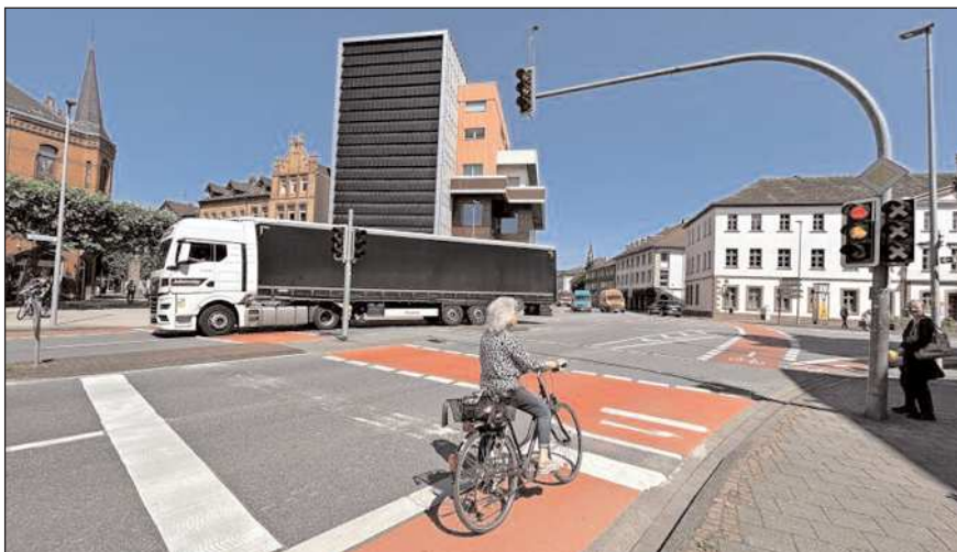
Neues Bild auf dem Haarmannplatz, aus der Fürstenberger Straße kommend. Die rot markierten Radfahrstreifen fallen auf. Noch fehlt die separate Lichtzeichenanlage für die Radfahrer . THOMAS SPECHT
