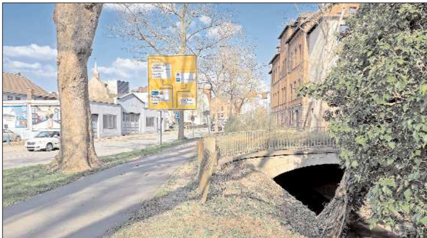
Die Brücke über die Holzminde (r.) im Bereich Hafendamm/Haarmannplatz soll ab Mai saniert werden.
